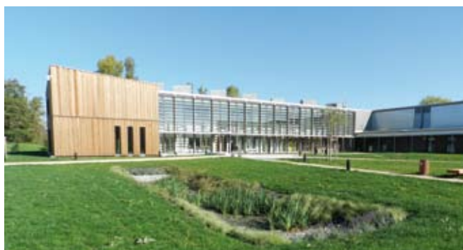
Pole ENR (pépinière d'entreprises) Cernay
