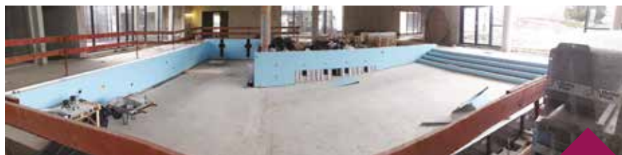
Construction de la nouvelle piscine intercommunale à Cernay.
